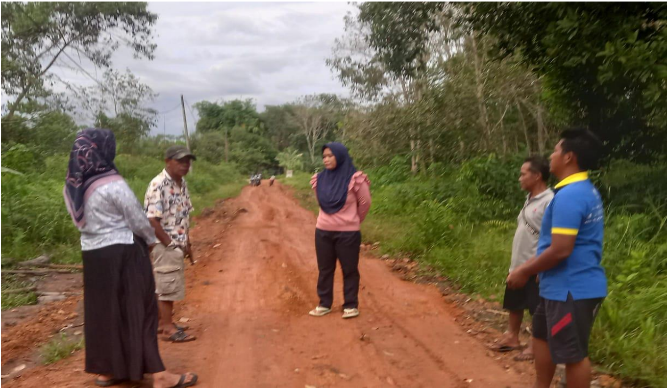
Photo dokumentasi pengecekan pekerjaan peningkatan jalan desa
